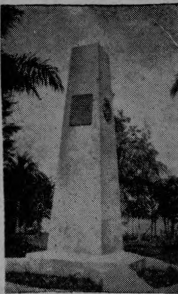
La gráfica corresponde al Monumento, recién construido. Las placas y medallones de sus costados se las robaron, quedando ahora solamente una columna dañada
